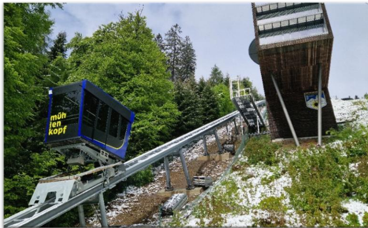
Der Bau schreitet voran: die Kabine des neuen Mühlenkopfliners befindet sich bereits auf den Schienen.
